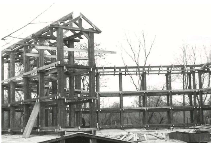
Ryc. 3. Budowa konstrukcji drewnianej, podtrzymującej gałęzie tarniny w tężni
