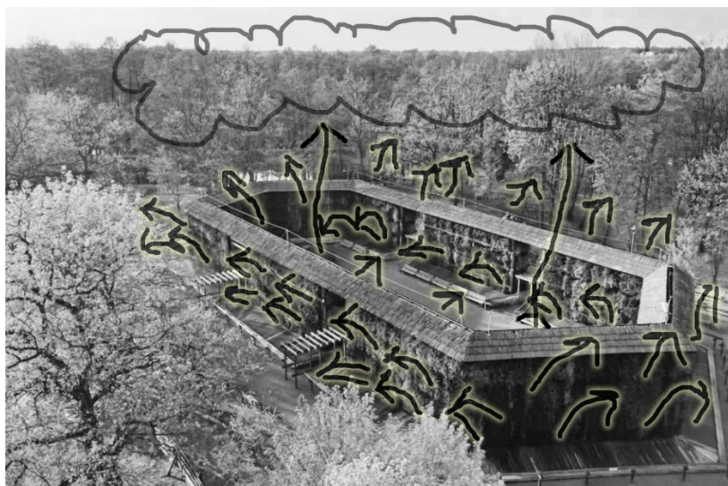
Ryc. 2. Tężnia solankowa w Konstancinie, widok z lotu ptaka, strzałkami pokazano schematycznie unoszące się w różnych kierunkach powietrze, nasycone wodą solankową
